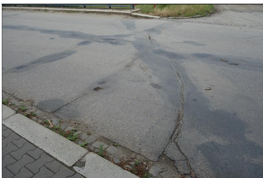
Detail vozovky v místě podpovrchového mostního závěru nad OP1.
