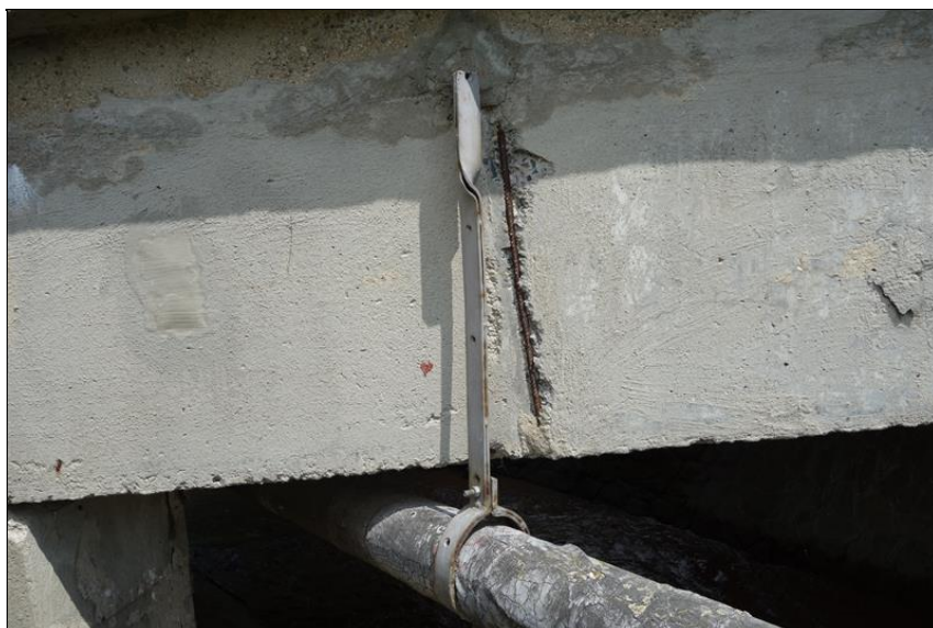
Zavěšení chráničky na pravý krajní nosník.
