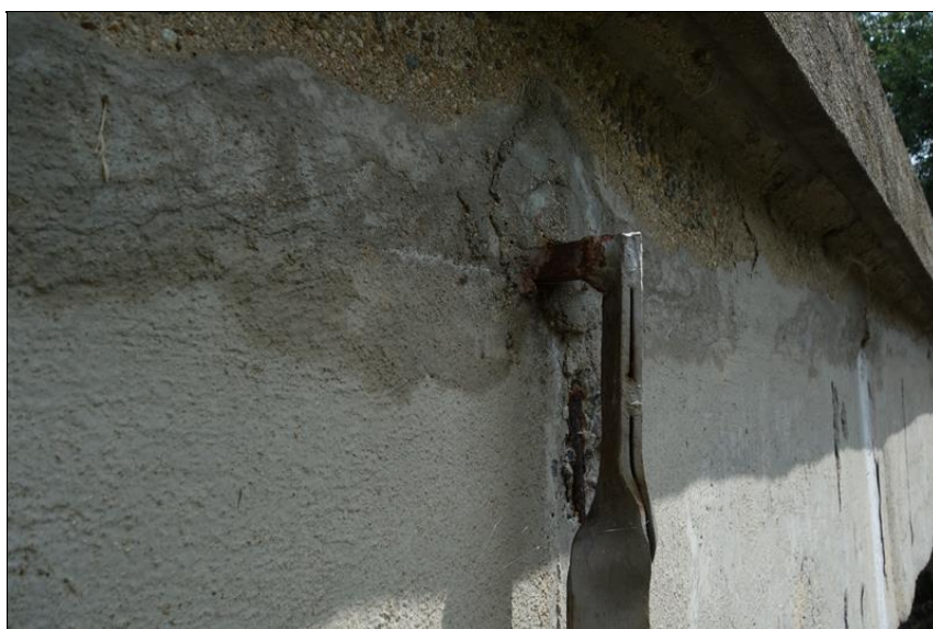
Detail zavěšení chráničky na pravý krajní nosník.
