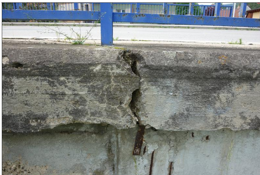
Detail dilatace levé římsy.
