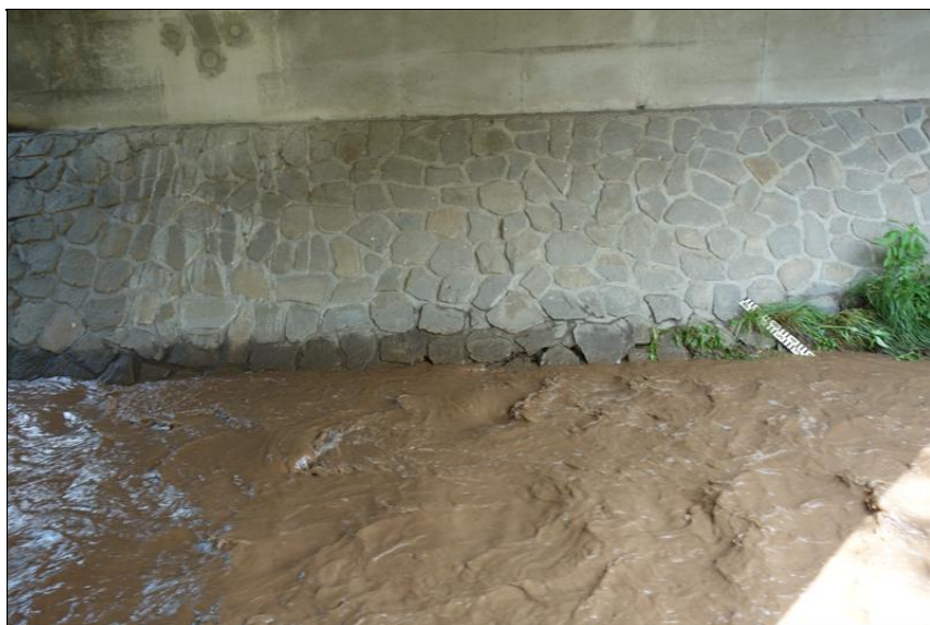
Opevnění svahu podél OP2.
